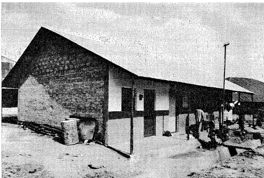
Vista da casa 79, reconstruída em Cupilom de Cima. Observa-se o melhoramento efetuado pelo inquilino: varanda, reboco, pintura, relógio de consumo e ligação elétrica.
